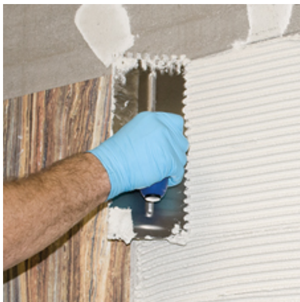
Aplique el mortero en una sola dirección con el lado dentado de la llana
