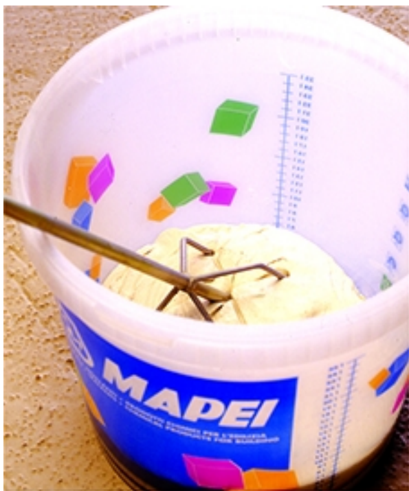
Mezcla de Mapeset Interiores con mezclador mecánico
