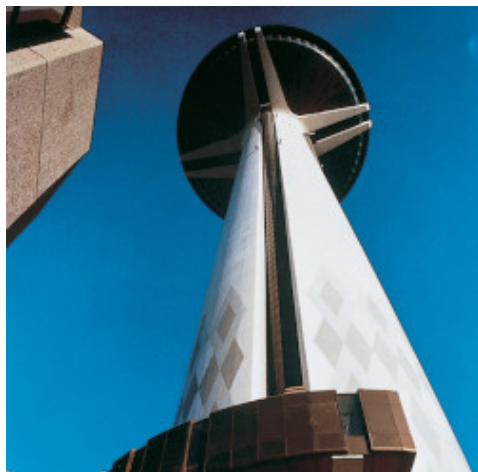
Piezas porcelánicas instaladas con Kerabond + Isolastic - Civic Center - North York Ontario (Canadá)
